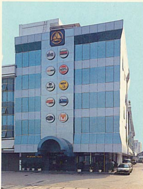
Gedung kantor pusat PT INTRACO PENTA Jl. P. Jayakarta No. 115, Blok C1-3 Jakarta
